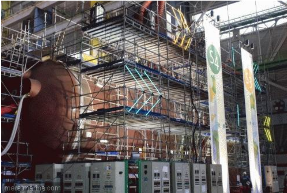
Le tronçon réalisé à Cherbourg (© : DCNS)
