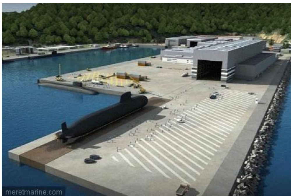
Le site de Sepetiba (© : DCNS)
