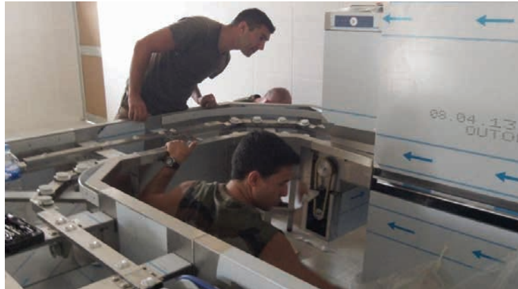
Installation de l'environnement d'une machine à laver la vaisselle industrielle : tapis roulant pour desserte des plateaux
